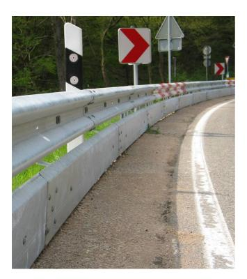
Der aktuelle Artikel "Schutzblech" in der Zeitschrift MOTORRAD (Ausgabe 14/2024) geht detaillierter auf die Fortschritte ein und hebt zurecht die Bedeutung des Unterfahrschutzes hervor: Eine zusätzliche untere Planke, die den direkten Anprall eines gestürzten Motorradfahrers an die starren und kantigen Pfosten verhindert und ein Entlanggleiten an der Planke ohne Hängenbleiben ermöglicht.
